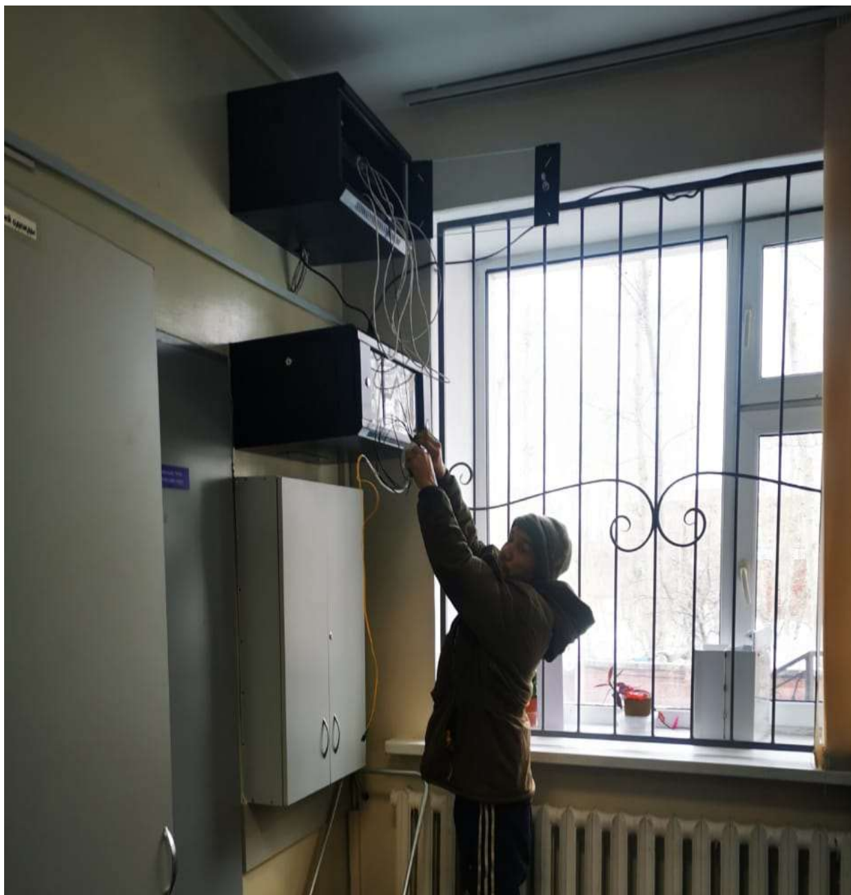
Рисунок 13 – установка телекоммуникационного шкафа
