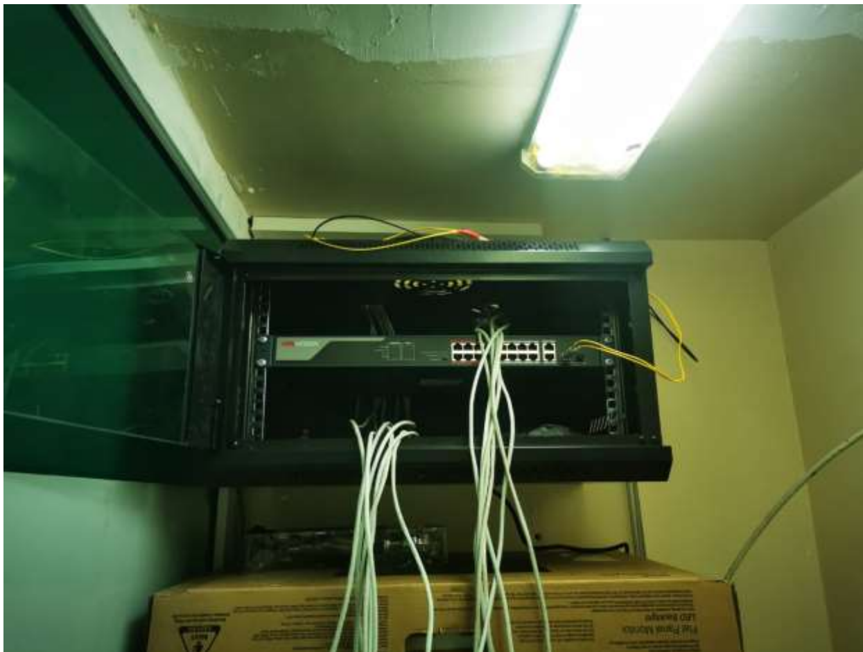
Рисунок 14 - установка коммутатора в телекоммуникационный шкаф
